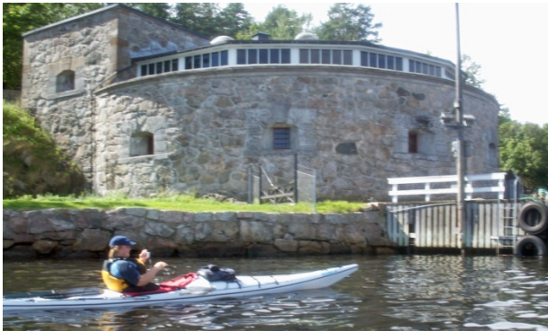
På veg mot kanalen mellom Kaholmene, Oscarsborg
